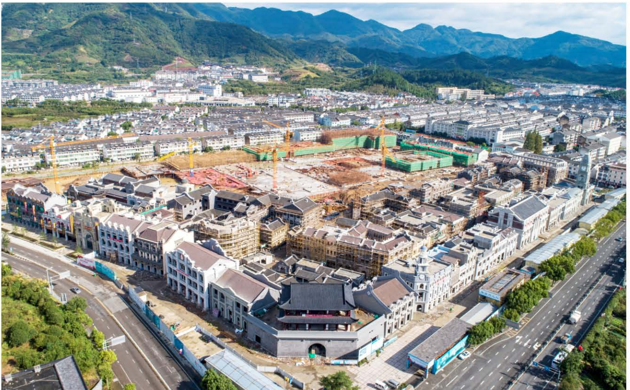
正在建设中的溪口民国风情街
