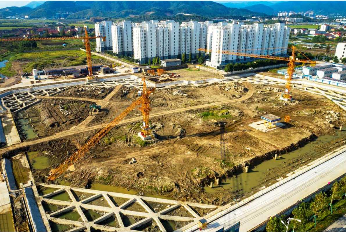
图为施工现场
